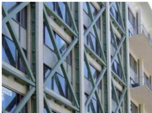
*Fig. 32. Ejemplo de intervención estructural para fortalecer los edificios sometidos a estrés sísmico.*
