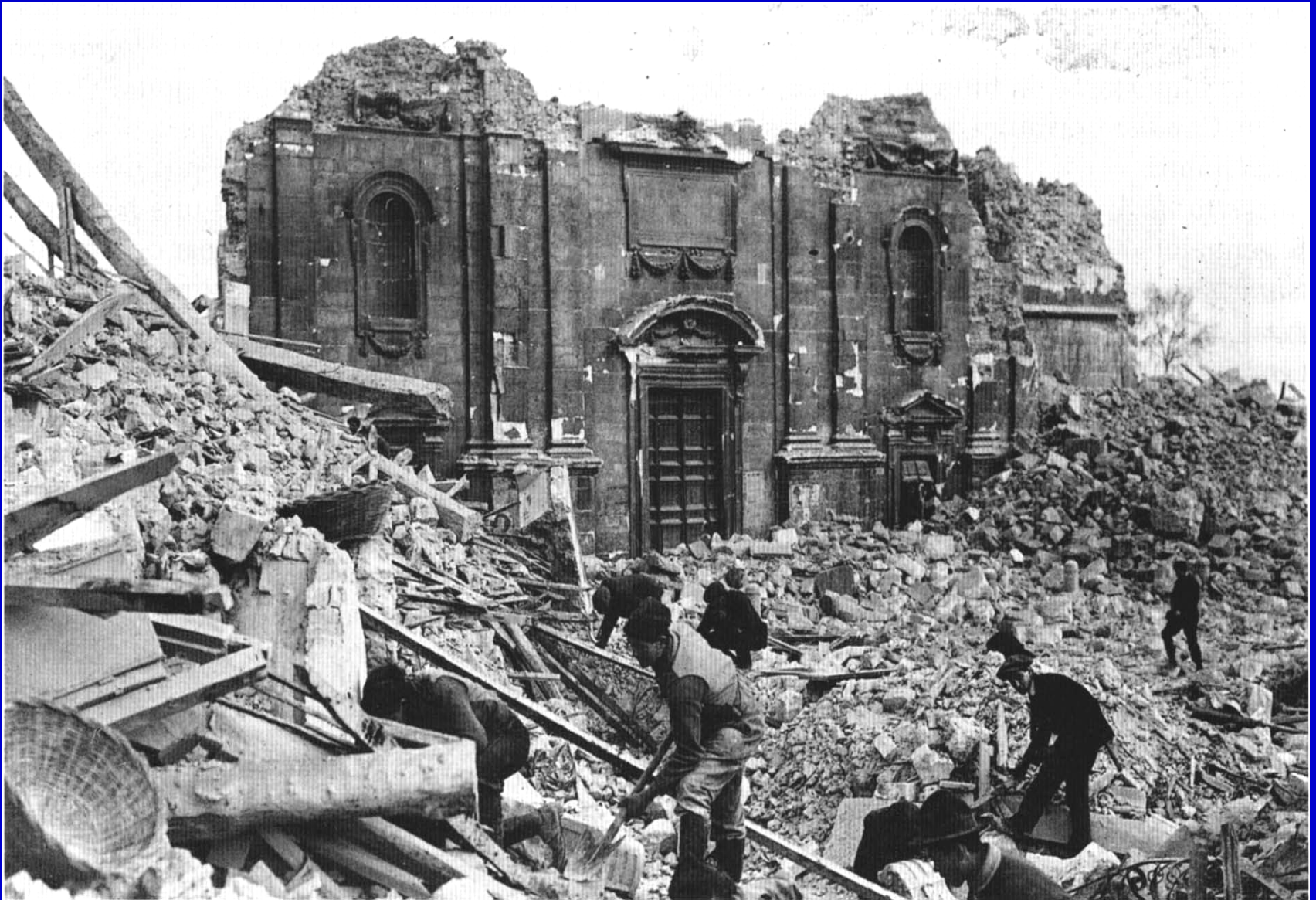
Avezzano Cathedral (Servizio Sismico Nazionale, 1999)
