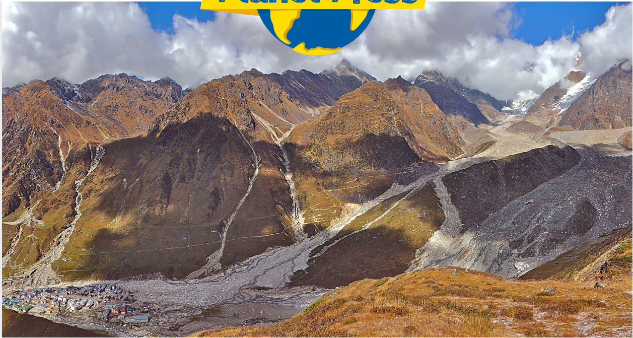
El deslizamiento de tierras de Kedarnath (Foto por Vaibhav Kaul, Universidad de Sheffield)
