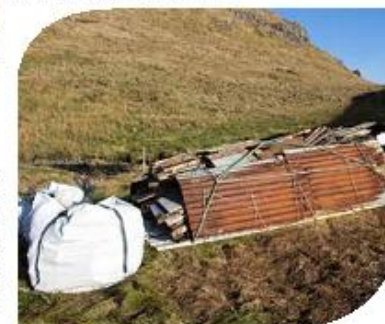
Etat du stockage des déchets triés au démantèlement terminé en 2016.
