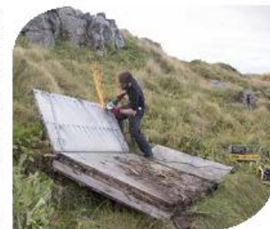
Désolidarisation des caisses-bois à la disqueuse.
