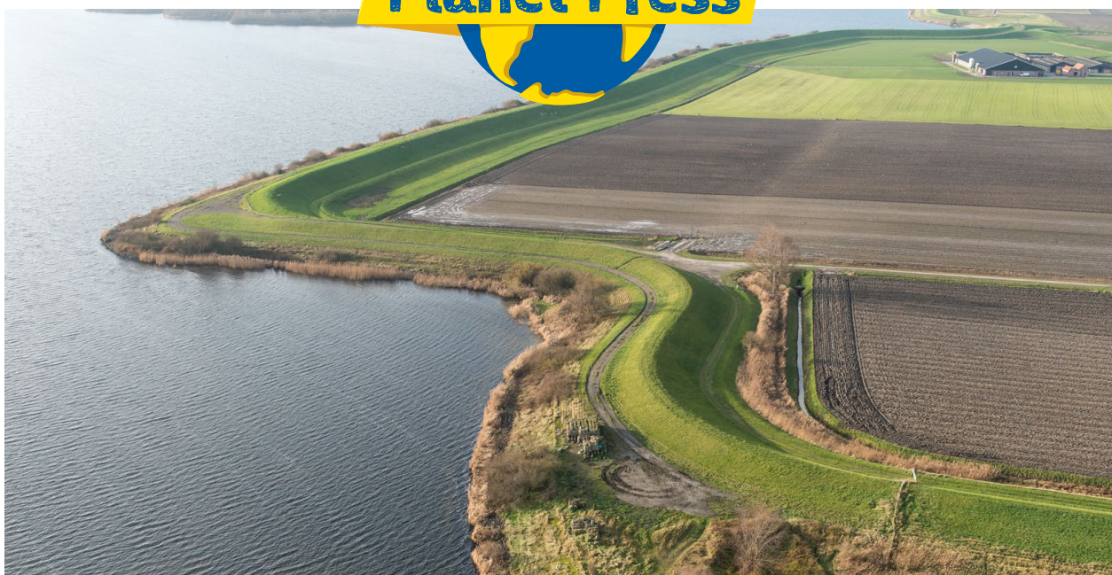
Nasip na Nizozemskem varuje kmetijske površine, ki ležijo pod gladino morja. Fotografija: Rijkswaterstaat, Nizozemsko Ministrstvo za infrastrukturo in okolje.
