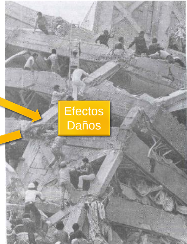
Edificio Nuevo León, en Tlatelolco, Ciudad de México, 19 de septiembre de 1985. (Foto: Aarón Sánchez, Unomásuno)
